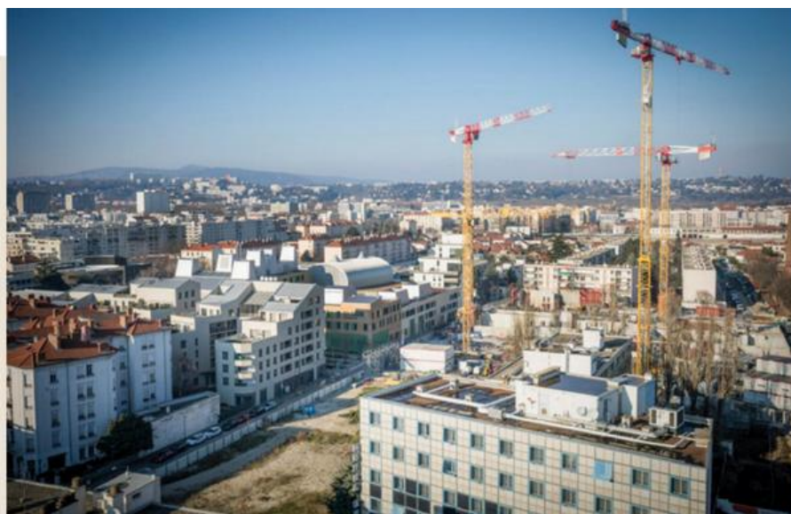
Chantier à Villeurbanne (Rhône). Dans le secteur de la construction, le manque à gagner de recettes de TVA pour l'Etat serait de 13% environ.
